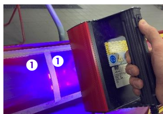
Exemple séchage mastic : lampe Hedson sur un des dommages n°1
